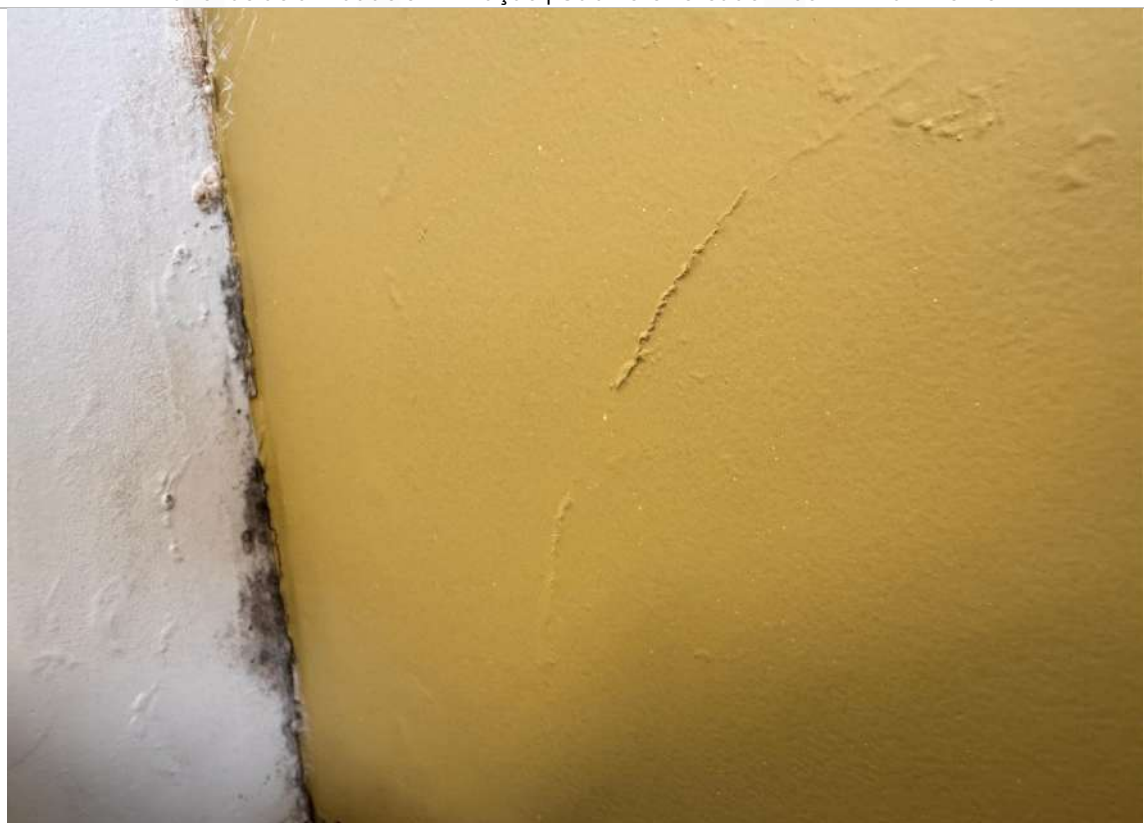
Bolor e Manchas de umidade e infiltração | Gabinete vereador 206 - 2º Pavimento
