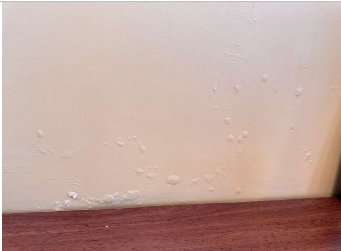
Bolhas na pintura devido umidade | Gabinete vereador 206 - 2º Pavimento
