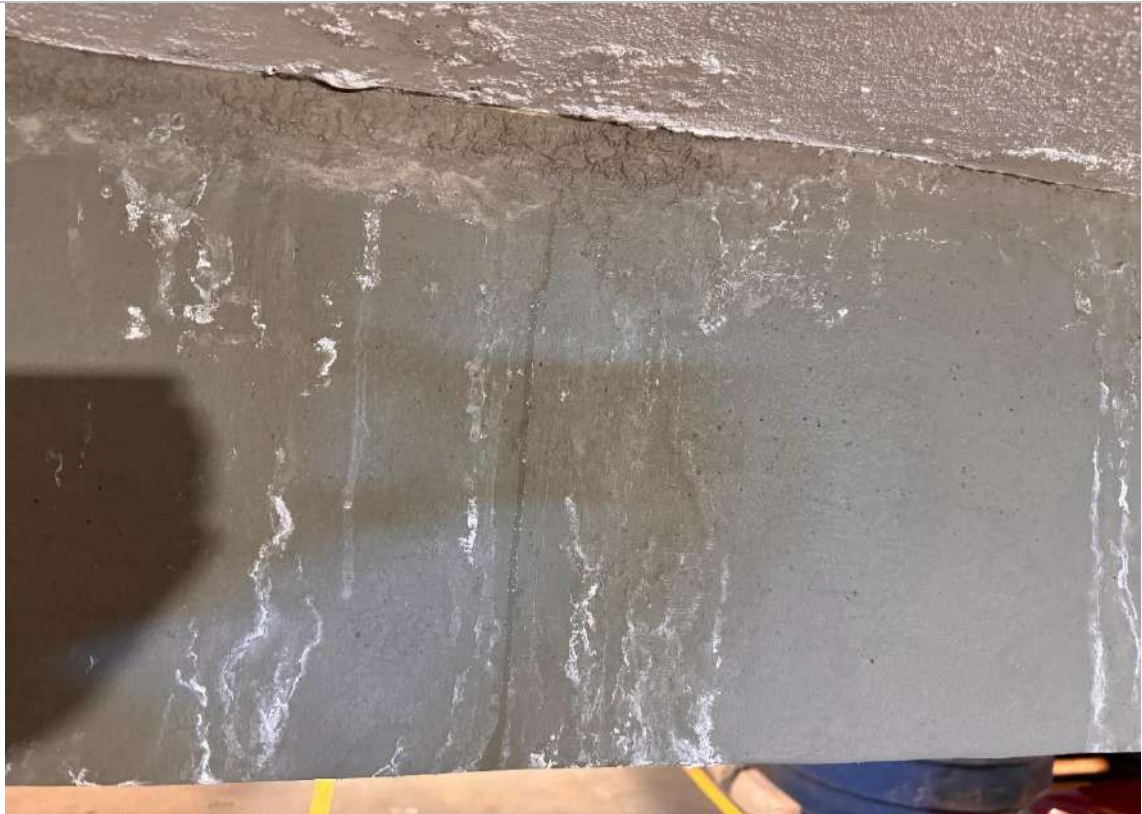
Eflorescências | Estacionamento - subsolo
