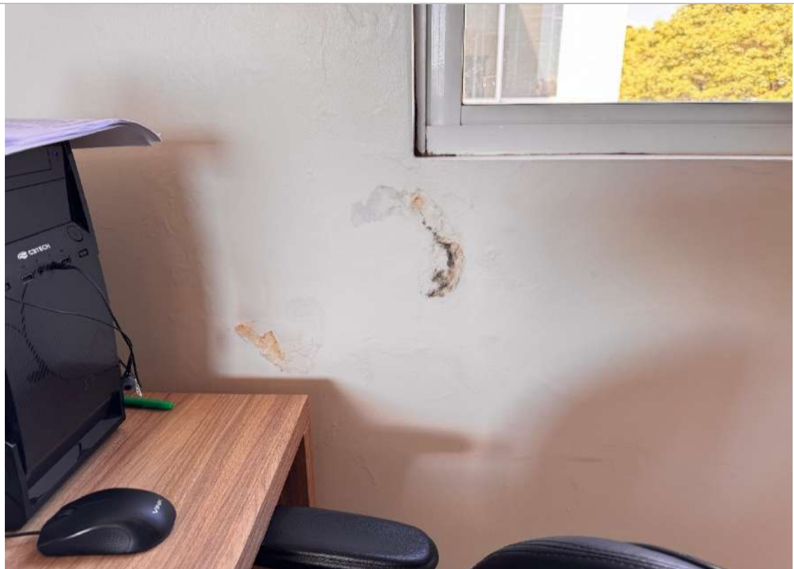
Manchas de umidade e deterioração da pintura | Sala de reunião – 3º Pavimento
