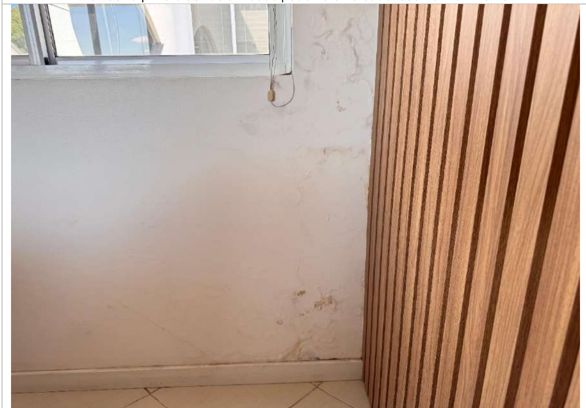
Manchas de umidade e deterioração da pintura | Sala de reuniao – 3º Pavimento
