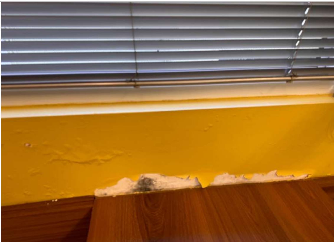
Descascamento da pintura por umidade | Departamento administrativo - térreo
