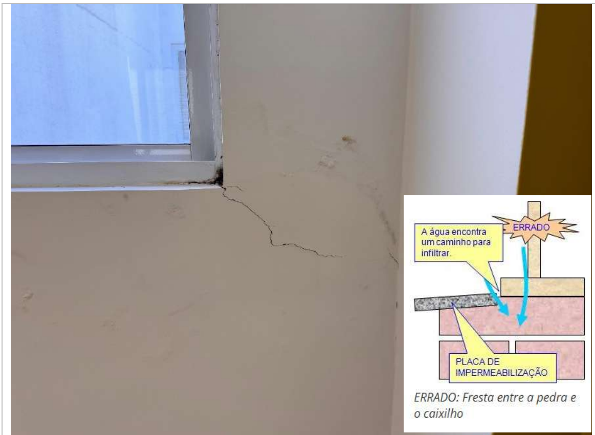
Peitoril suscetível a infiltração: placa impermeável não foi instalada de maneira correta
