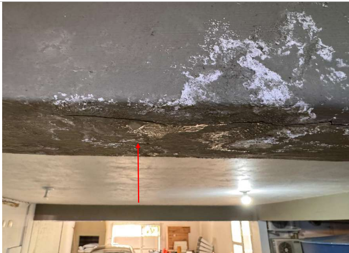
Goteira devido falha do sistema de drenagem de ar condicionado | Estacionamento - subsolo
