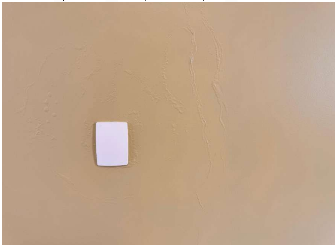
Bolhas na pintura devido umidade | Procuradoria Especial da Defesa – 2º Pavimento
