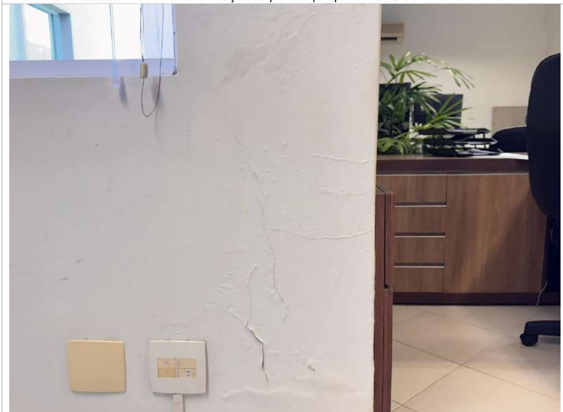
Manchas de umidade e deterioração da pintura | Departamento administrativo - térreo
