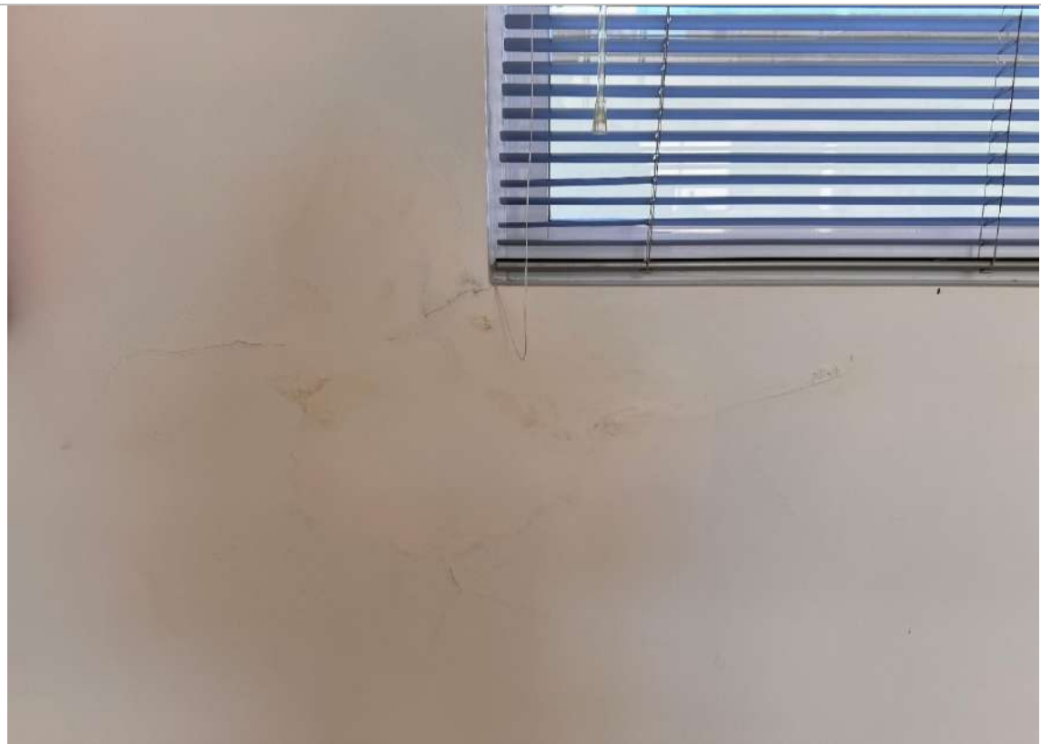
Manchas de umidade e deterioração da pintura | Corredor – 1º Pavimento
