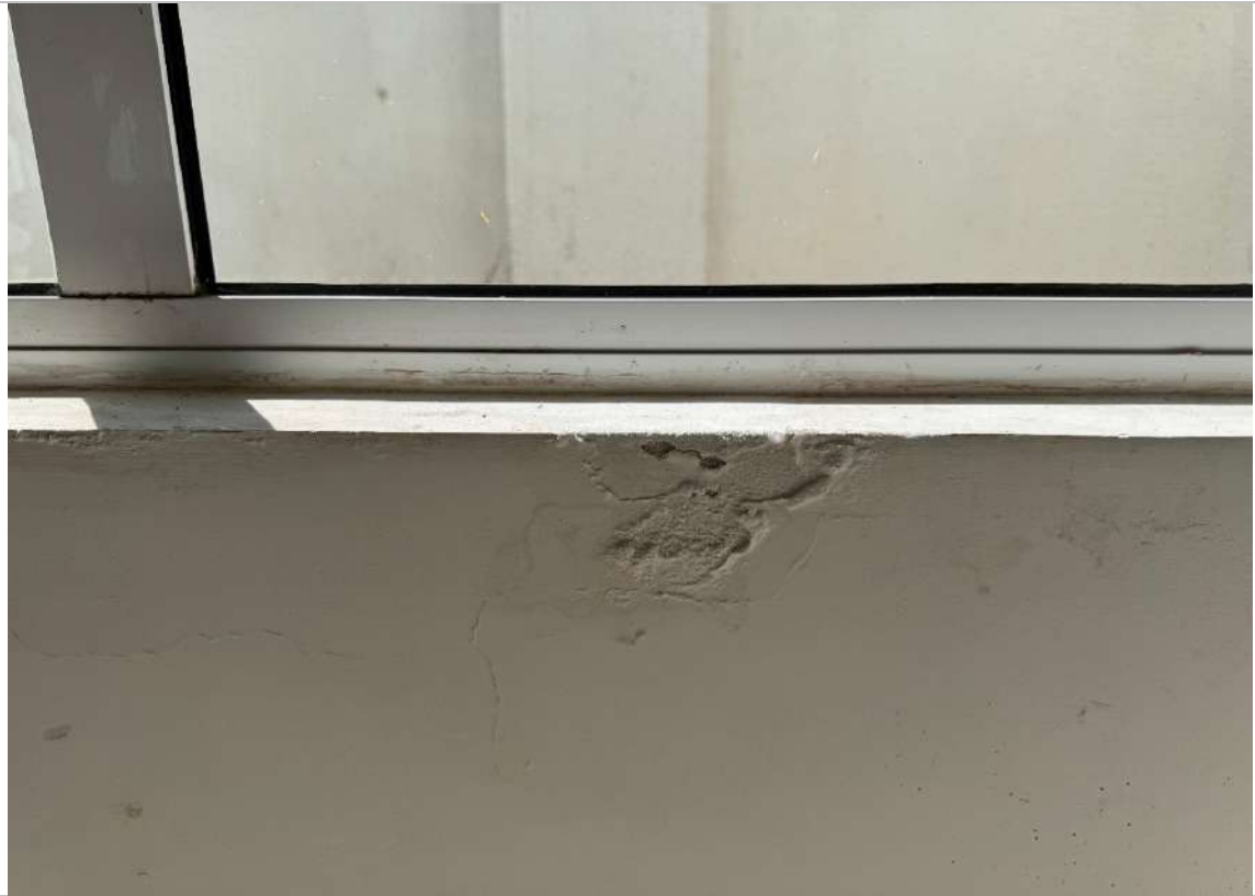
Infiltração | Cozinha - subsolo
