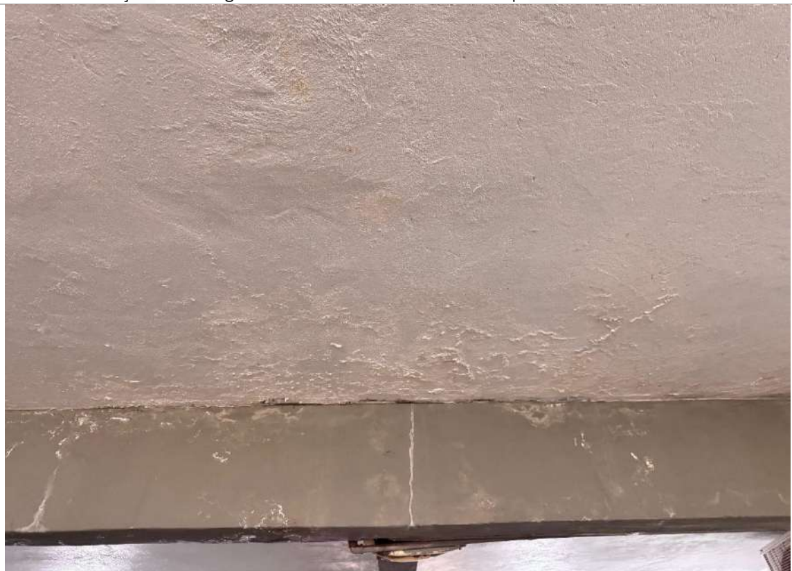
Manchas de infiltração e eflorescência | Estacionamento - subsolo
