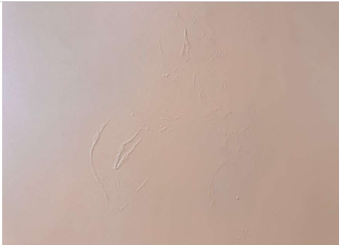
Bolhas na pintura devido umidade | Procuradoria Especial da Defesa – 2º Pavimento
