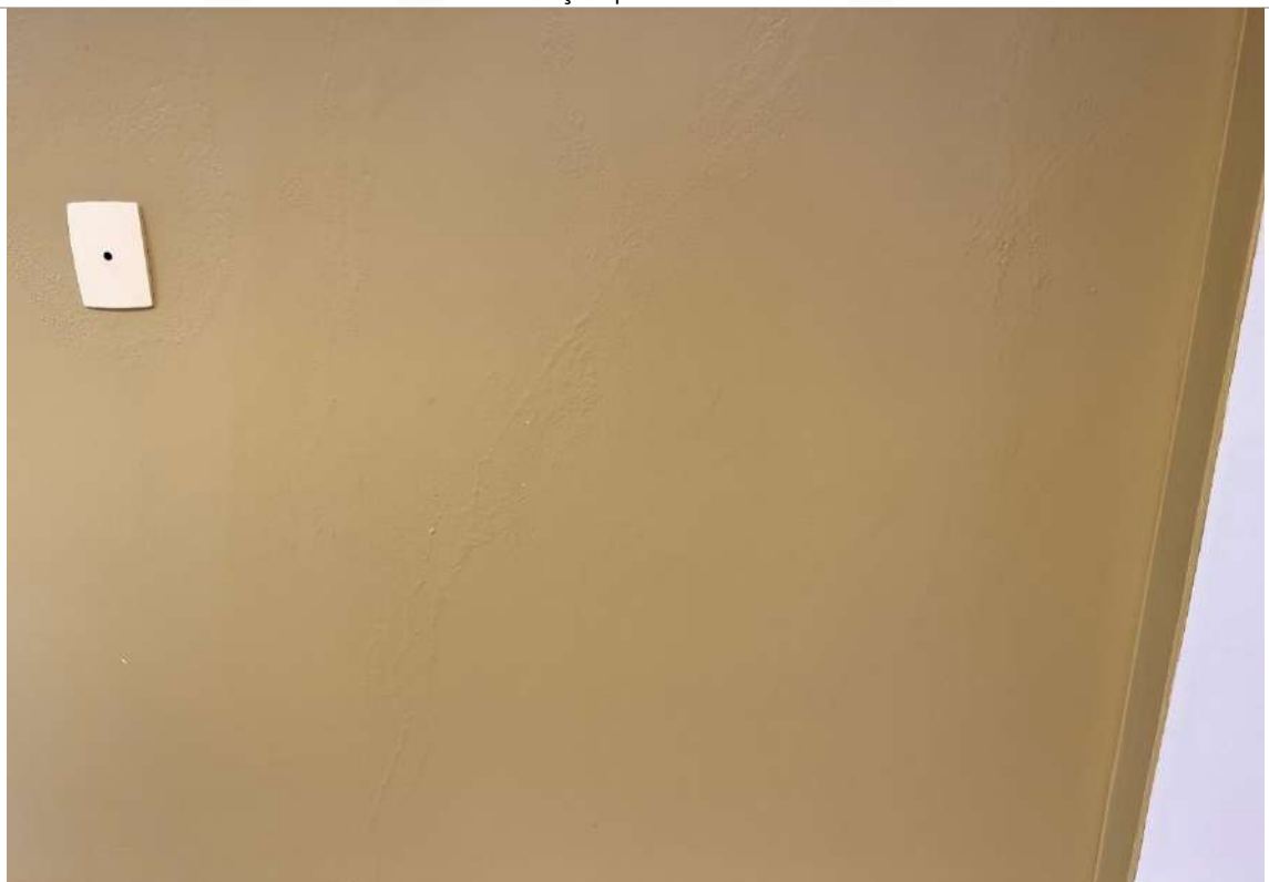
Bolhas na pintura devido umidade | Gabinete vazio T03 - térreo
