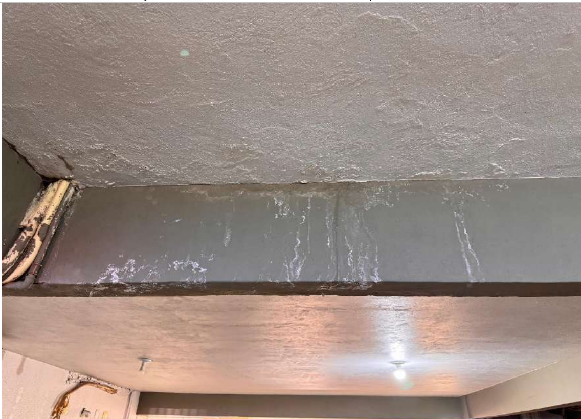
Eflorescências | Estacionamento - subsolo
