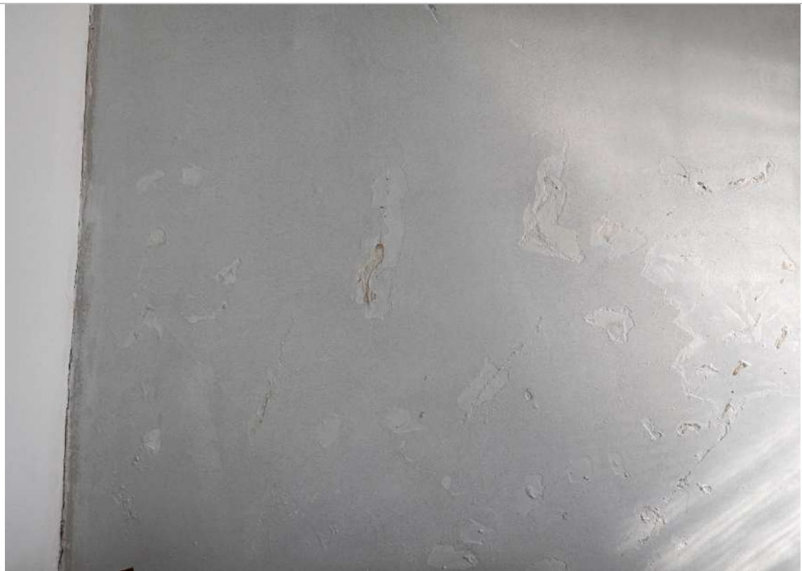
Descascamento por umidade | Gabinete Vereador 305 – 3º Pavimento
