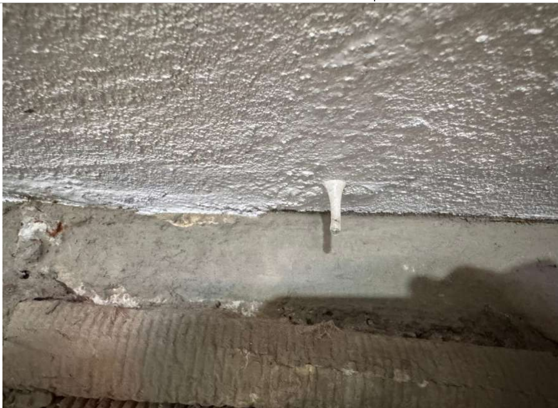
Eflorescências | Estacionamento - subsolo
