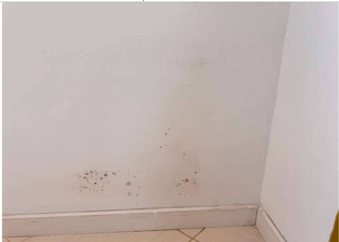
Manchas de umidade e deterioração da pintura | Procuradoria Especial da Defesa – 2º Pavimento
