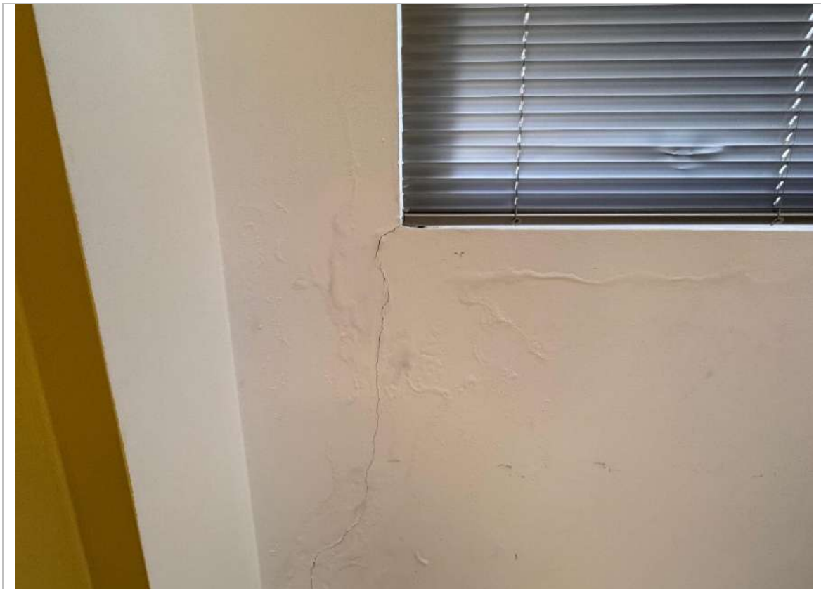
Manchas de umidade e deterioração da pintura | Departamento de comunicações – 1º Pavimento
