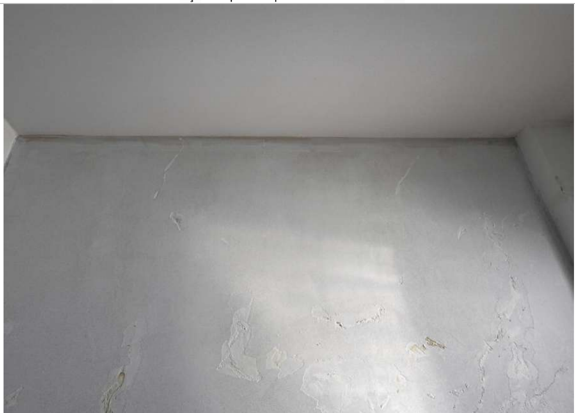
Descascamento por umidade | Gabinete Vereador 305 – 3º Pavimento
