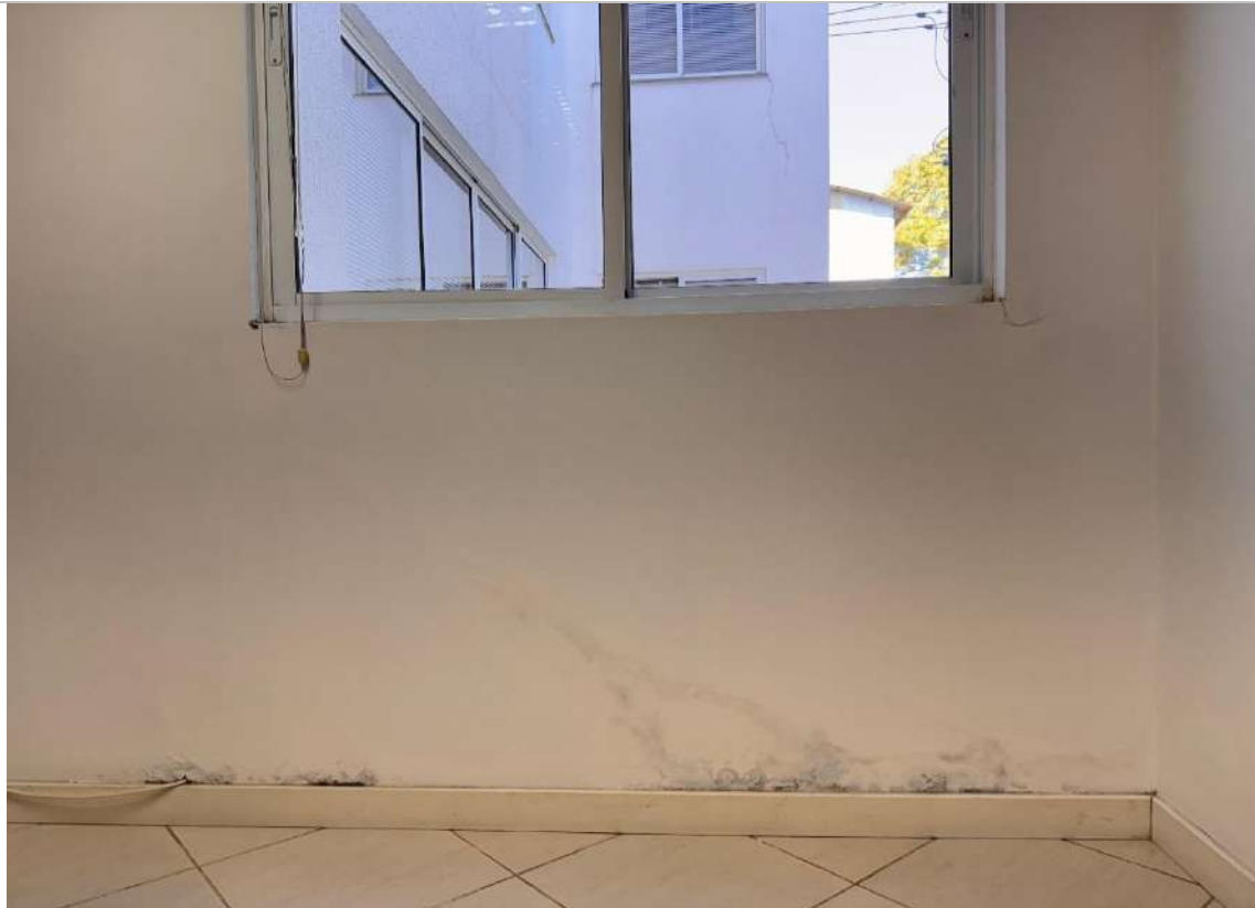
Manchas de umidade e deterioração da pintura | Gabinete vazio T03 - térreo
