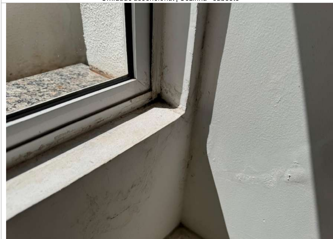
Peitoril executado de forma inadequada | Cozinha - subsolo
