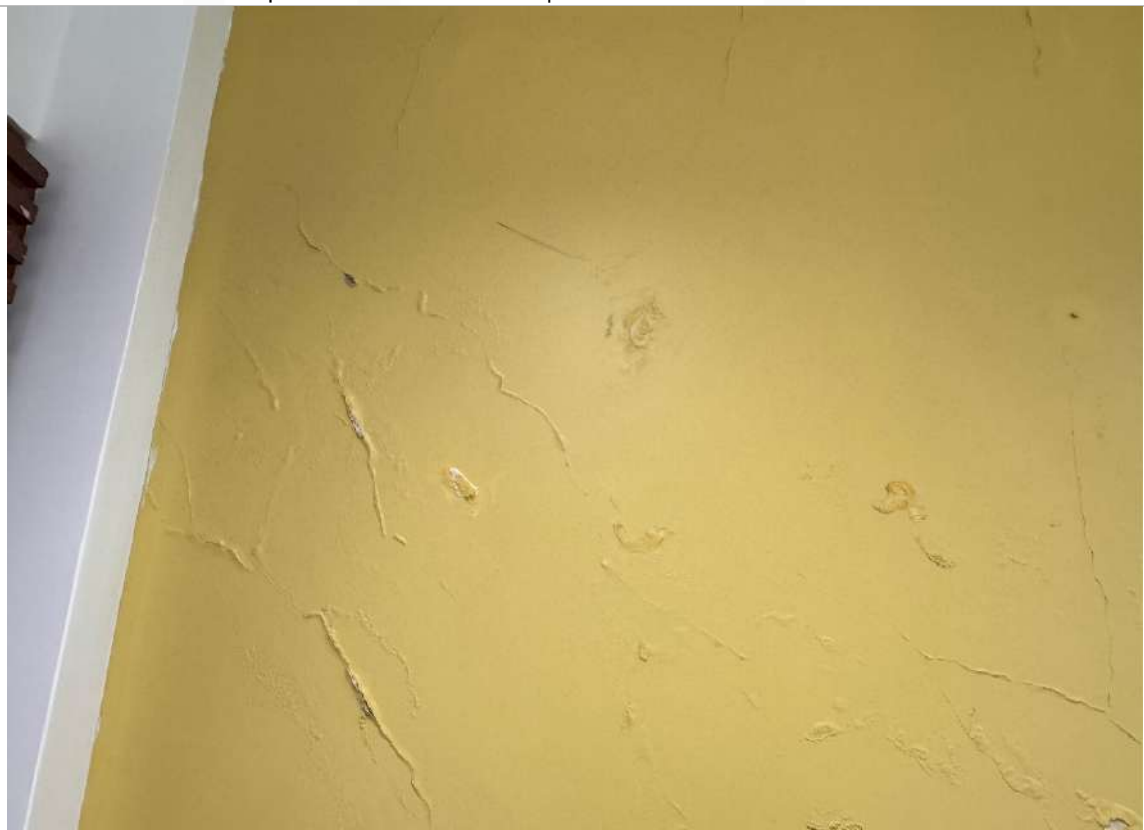
Bolhas na pintura devido umidade | Gabinete Vereador 305 – 3º Pavimento
