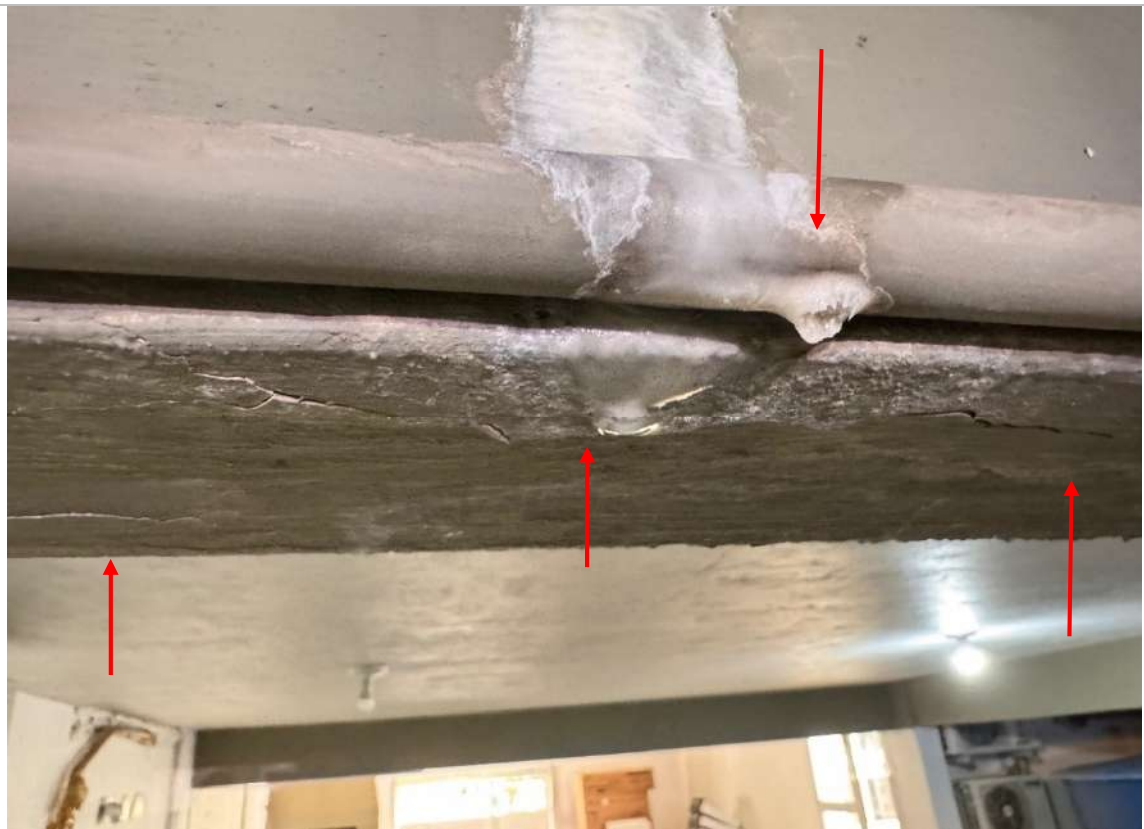
Eflorescências e trincas em elementos de concreto armado | Estacionamento - subsolo
