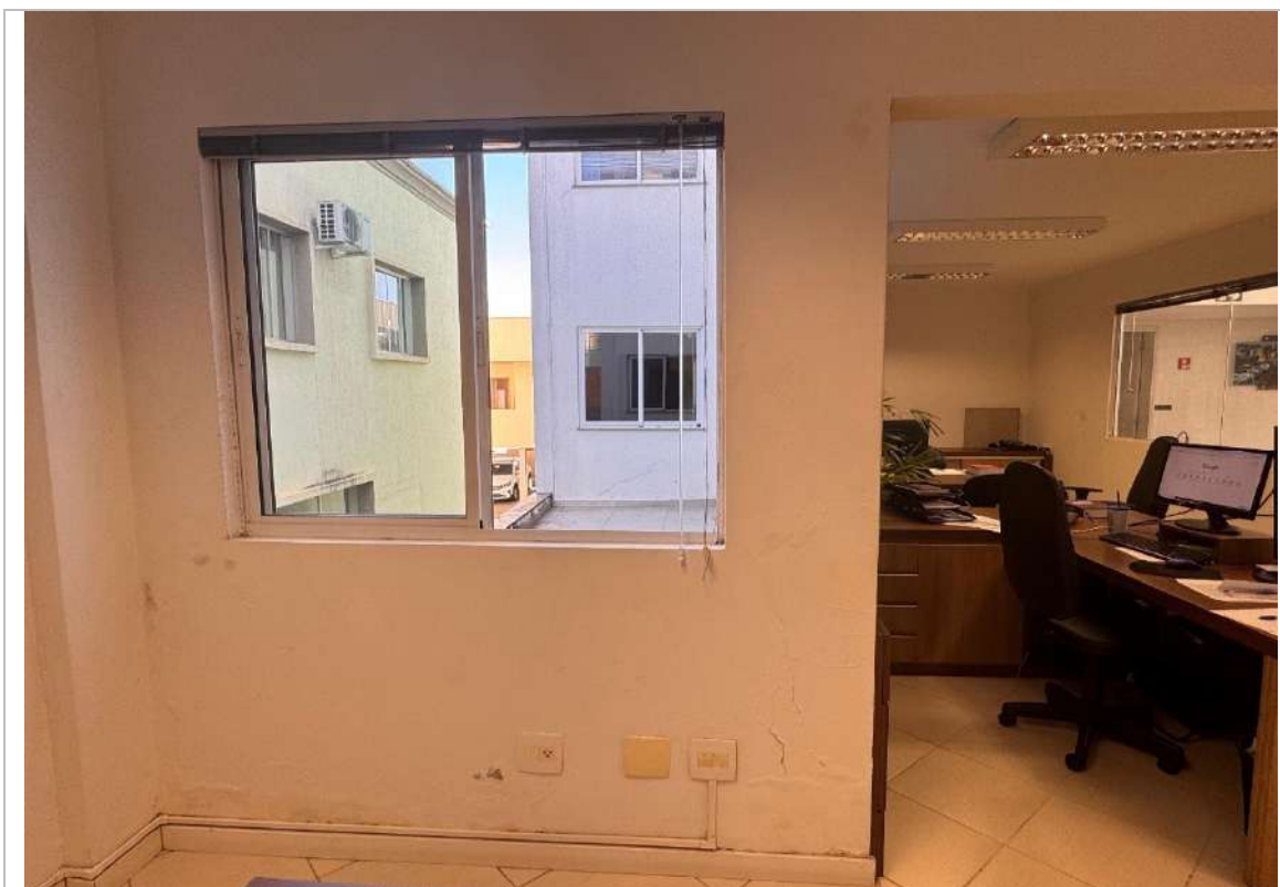
Manchas de umidade e deterioração da pintura | Departamento administrativo - térreo
