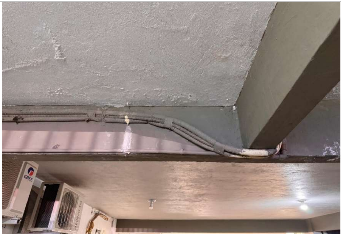
Tubulação de drenagem do sistema de ar condicionado | Estacionamento - subsolo
