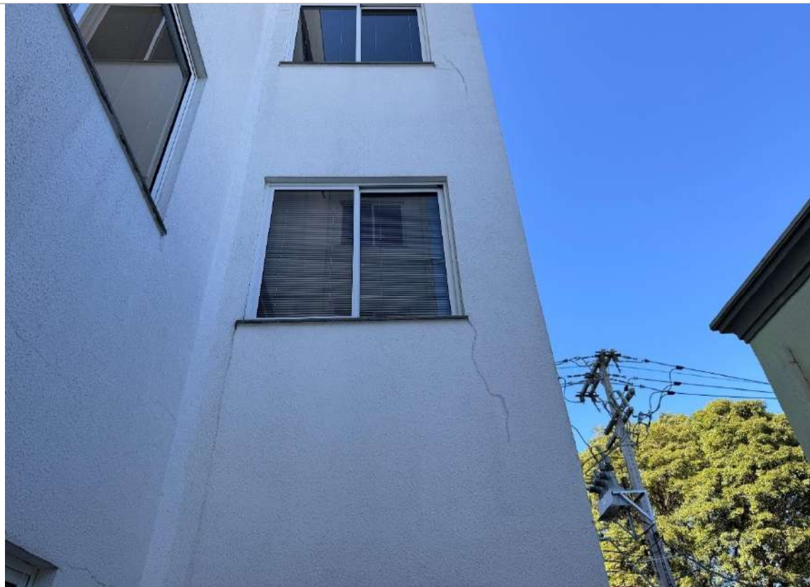
Trincas inferiores à esquadria - Ausência de contraverga e infiltração pelo peitoril
