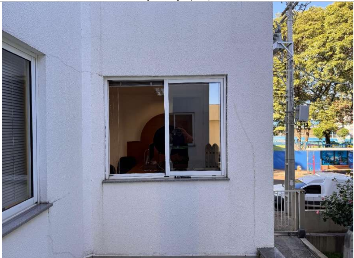
Trincas que indicam a presença intermitente de umidade na parede
