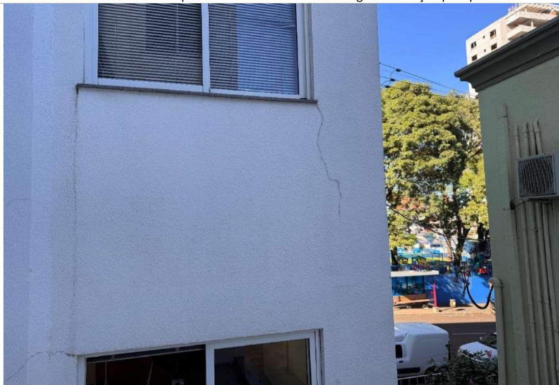
Trincas inferiores à esquadria - Ausência de contraverga e infiltração pelo peitoril
