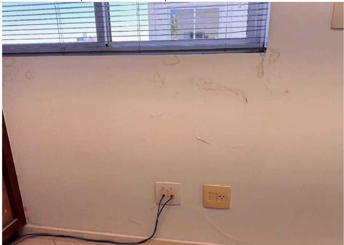
Manchas de umidade e infiltração | Gabinete vereador 206 - 2º Pavimento
