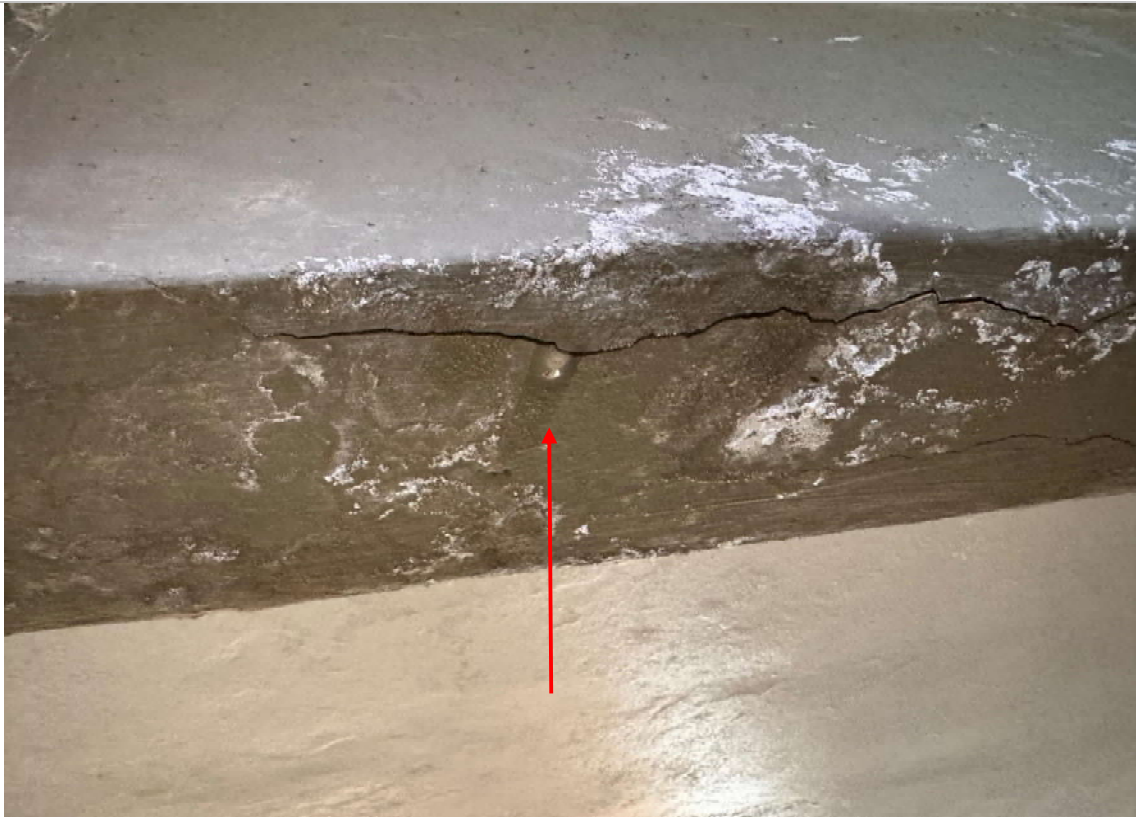
Trinca e infiltração em elemento de concreto armado | Estacionamento - subsolo
