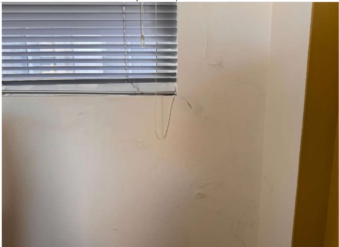
Manchas de umidade e deterioração da pintura | Contabilidade 1º Pavimento
