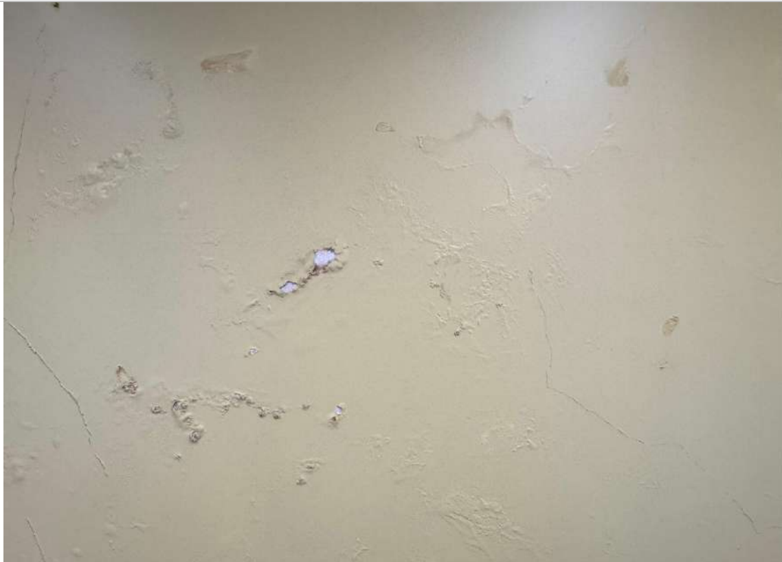
Bolhas na pintura devido umidade | Gabinete Vereador 305 – 3º Pavimento
