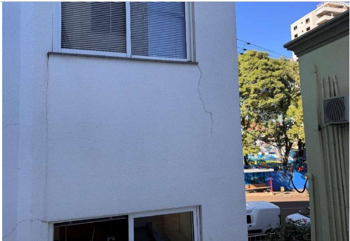
Peitoril suscetível a infiltração: placa impermeável não foi instalada de maneira correta
