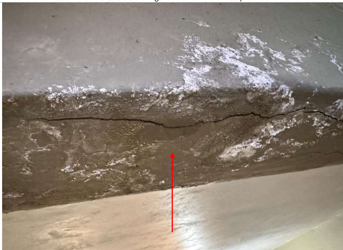
Trinca em elemento de concreto armado | Estacionamento - subsolo
