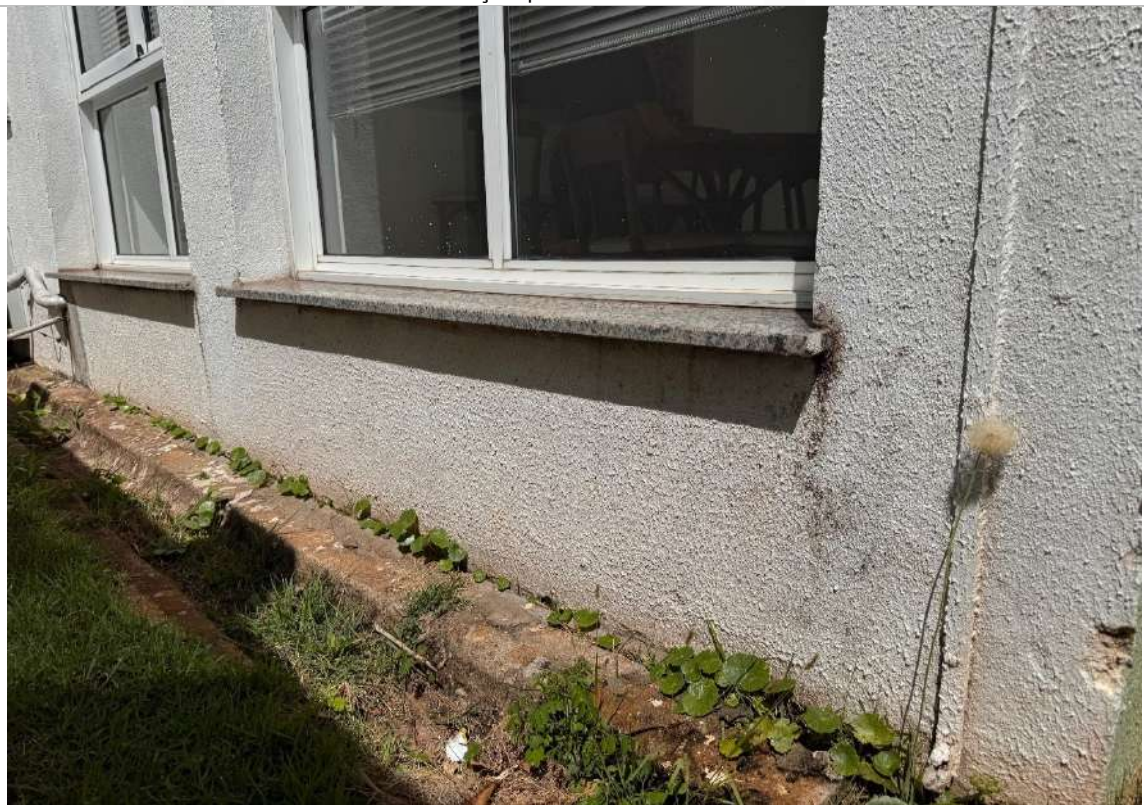
Infiltração | Cozinha - subsolo
