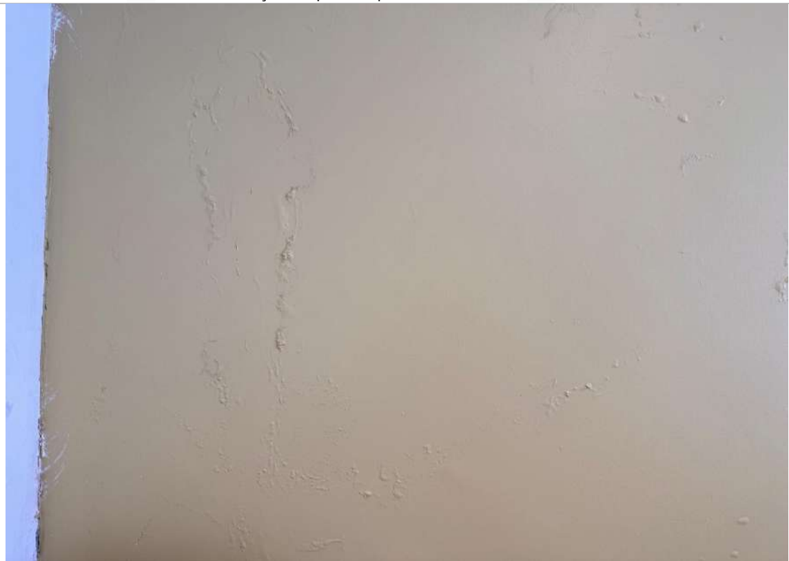
Bolhas na pintura devido umidade | Gabinete vereador 206 - 2º Pavimento
