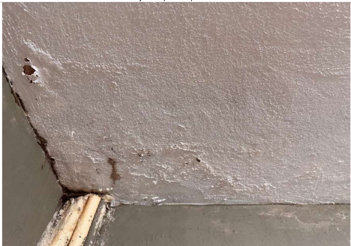
Umidade e deterioração da pintura | Estacionamento - subsolo
