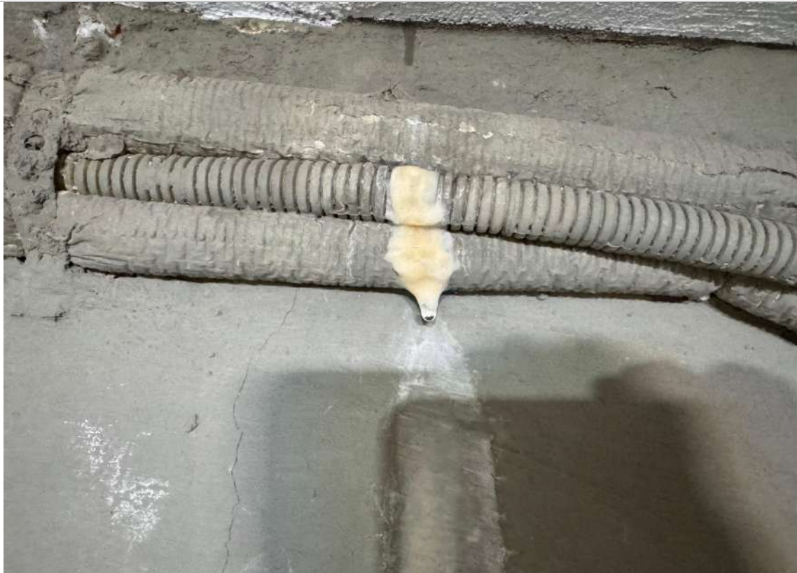
Eflorescências e trincas em elementos de concreto armado | Estacionamento - subsolo
