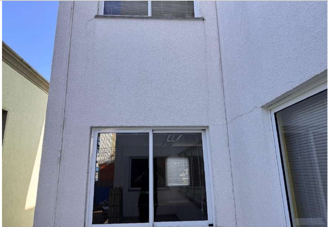
Infiltração de água pelo peitoril
