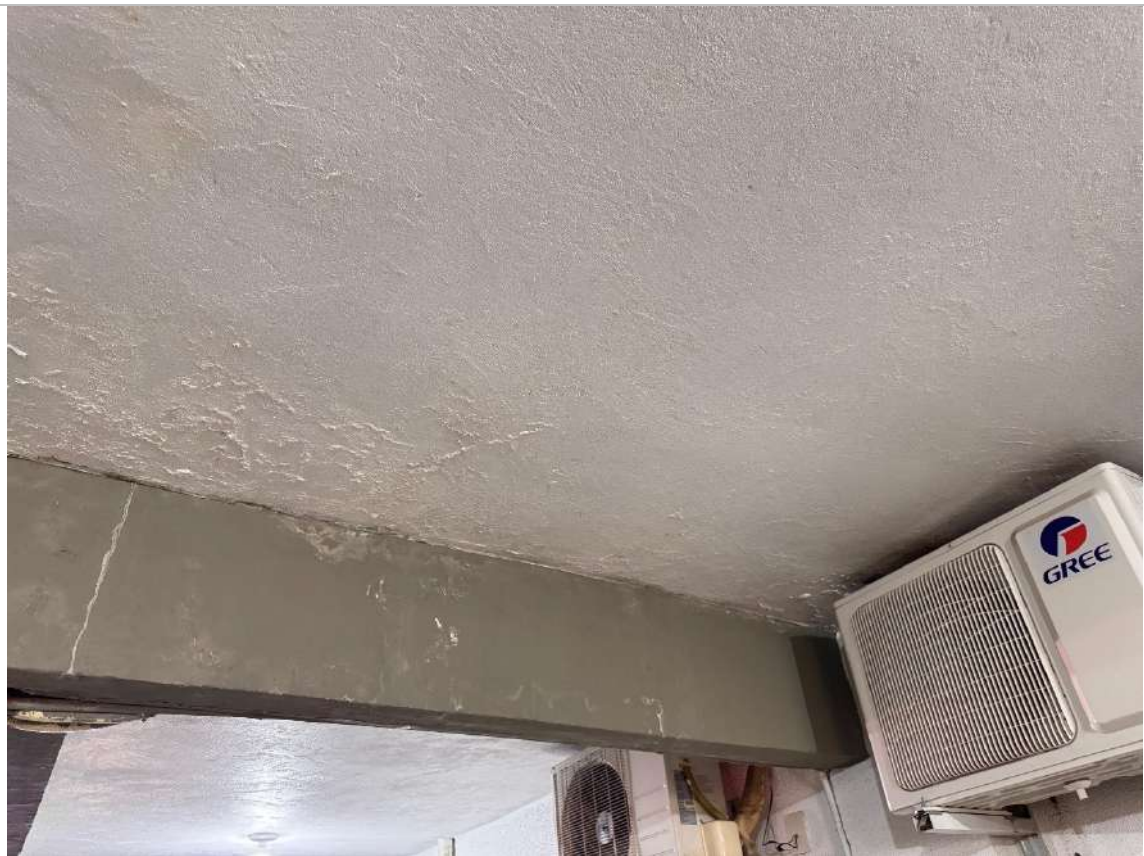
Umidade e deterioração da pintura | Estacionamento - subsolo
