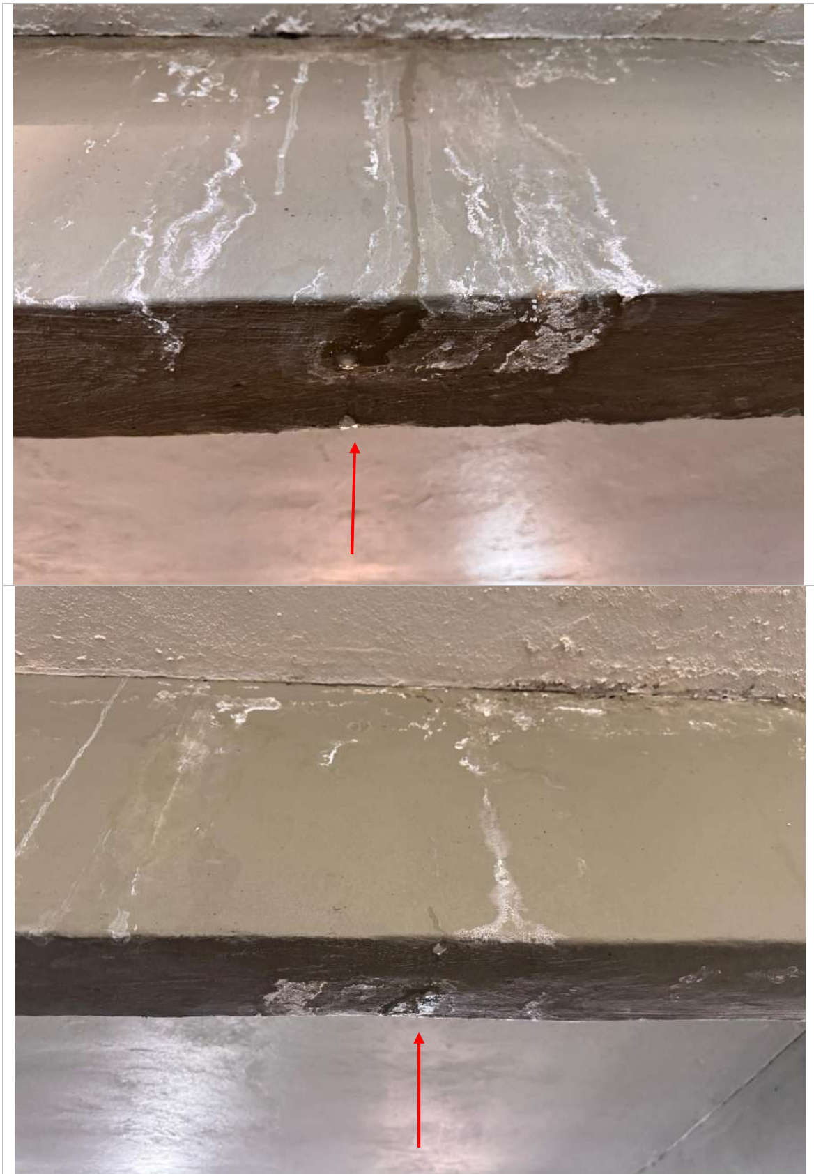
Umidade constante, eflorescência em elementos estruturais | Estacionamento subsolo
