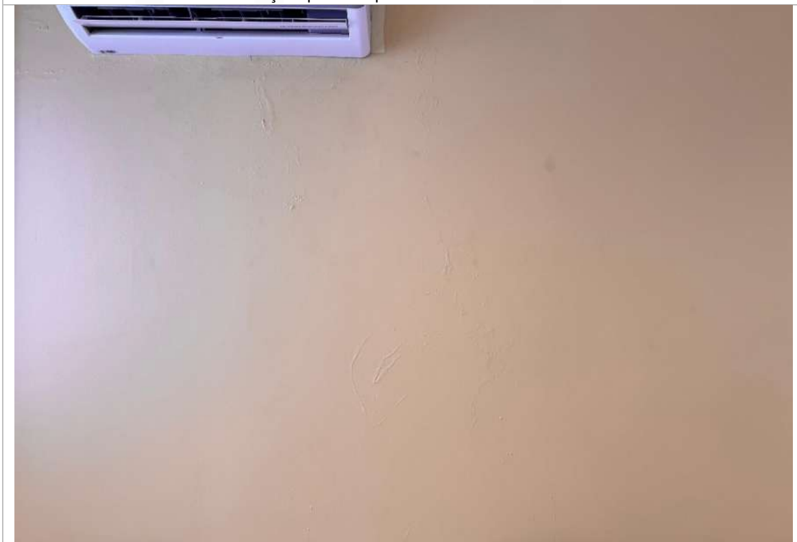
Bolhas na pintura devido umidade | Procuradoria Especial da Defesa – 2º Pavimento
