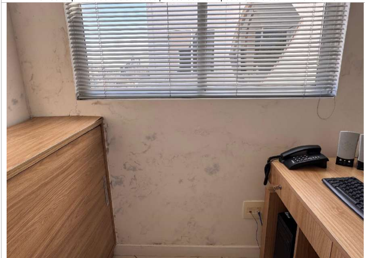
Manchas de umidade e deterioração da pintura | Gabinete Vereador 305 – 3º Pavimento
