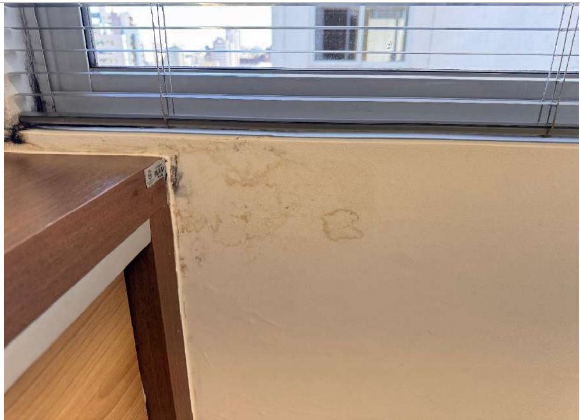
Manchas de umidade e infiltração | Gabinete vereador 206 - 2º Pavimento
