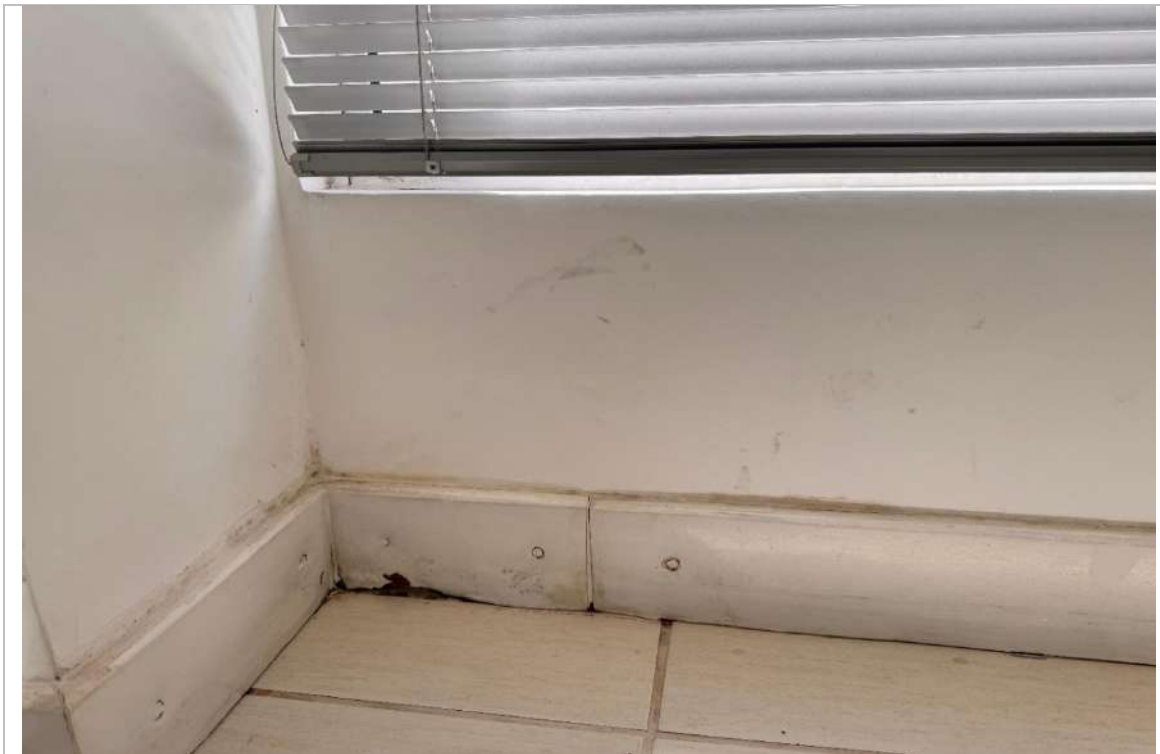
Umidade ascensional | Cozinha - subsolo
