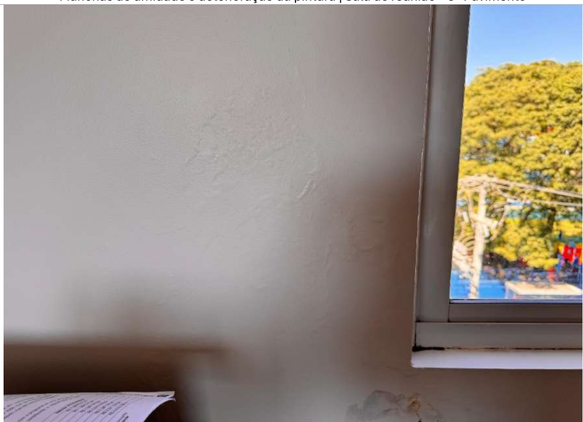
Manchas de umidade e deterioração da pintura | Sala de reunião – 3º Pavimento
