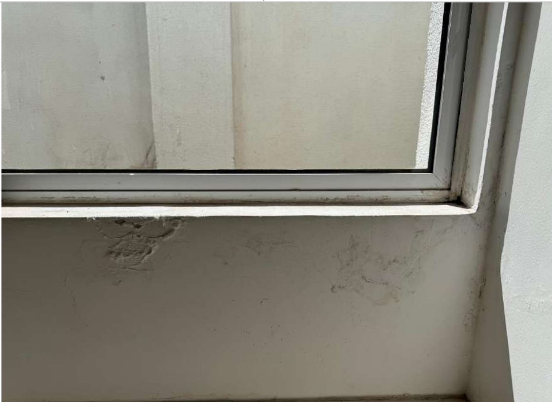
Infiltração | Cozinha - subsolo
